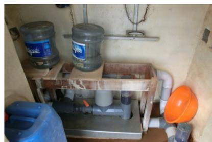
Le système de chloration goutte à goutte sur le réseau
