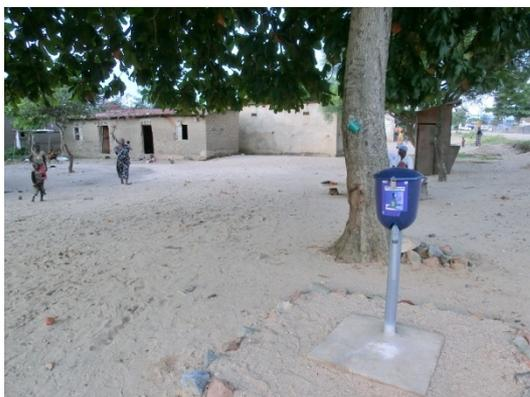
*Distributeur automatique de chlore liquide à quelques dizaines de mètres du lac*
